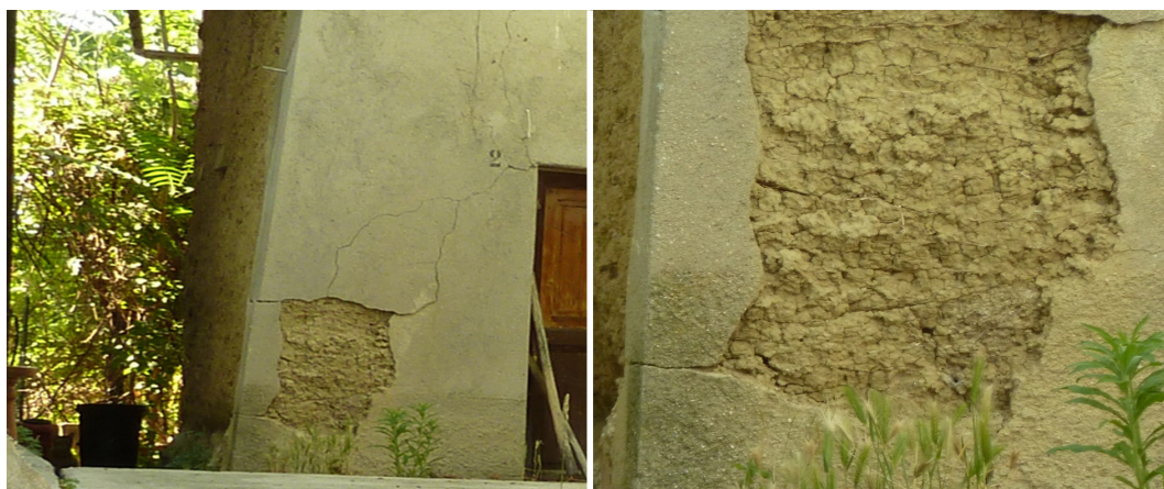
Fig. 3.- Manoppello (Pescara). Località Colle Roana. Casa in terra cruda di piccole dimensioni, a due livelli, con una scala esterna; l'edificio presenta un intonaco cementizio, parzialmente distaccato. Fonte: Claudio Mazzanti.
