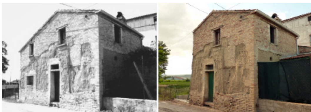
Fig. 7.- Sant'Omero (Teramo). Località Case Alte. Casa in terra cruda sopraelevata con una nuova muratura in mattoni. A sinistra: stato di fatto nel 1997. Fonte: Case in terra cruda. Censimento 1999. A destra: situazione attuale. Fonte: Claudio Mazzanti.
