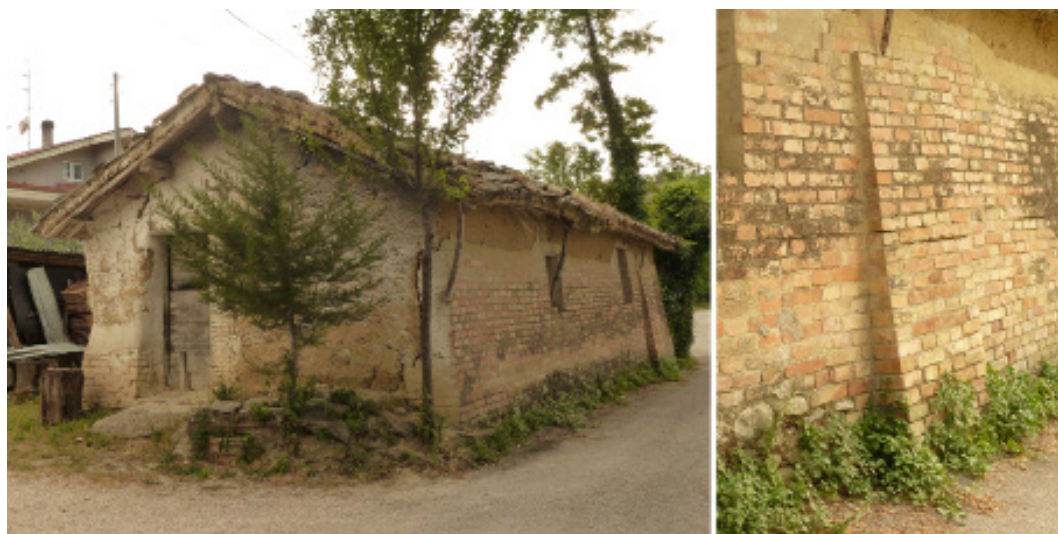
Fig. 4.- Bucchianico (Chieti). Strada comunale Costa Vasari. Casa in terra cruda, di modeste dimensioni, a pianta rettangolare; la parete esposta a nord presenta un rivestimento in mattoni cotti, con un contrafforte nella parte terminale dell'edificio. Fonte: Claudio Mazzanti.
