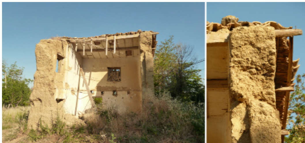
Fig. 1.- Manoppello (Pescara). Casa in terra cruda; edificio allo stato di rudere con caratteri tipici della costruzione originaria, come l'incannucciato al di sotto del manto di copertura in coppi di laterizio. Fonte: Claudio Mazzanti.
