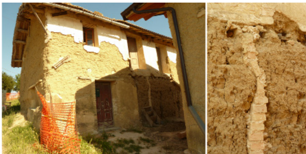
Fig. 5.- Casalinocontrada (Chieti). Località Malandra Vecchia, aggregato rurale; in uno degli edifici, la terra cruda è stata sostituita con mattoni cotti, in corrispondenza di una lesione verticale del muro. Fonte: Claudio Mazzanti.
