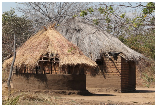
Fig. 4.-Ejemplo de embarrado en nuevas construcciones ubicadas en el valle del río Luangwa, Zambia. Fuente: M.M. Barbero-Barrera.
