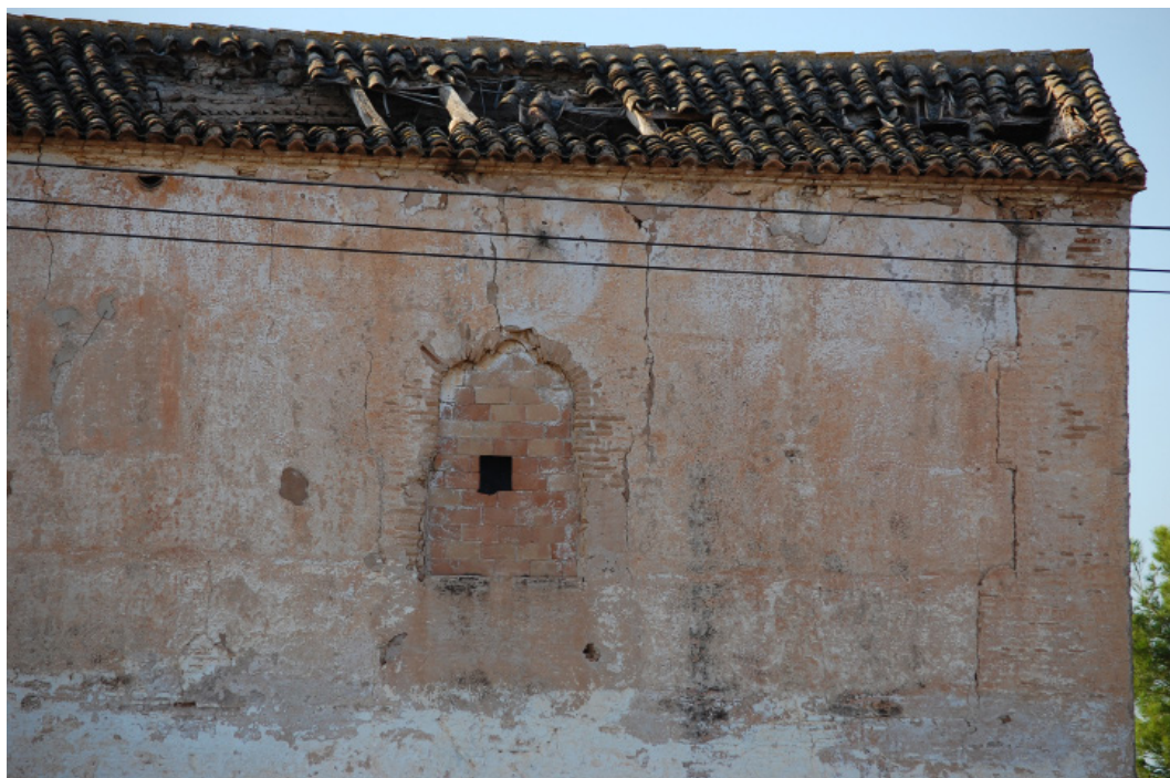
Fig. 5. Detalle del muro de tapia mixta donde se observa la junta constructiva que recorre la traba entre la tapia y la fábrica de ladrillo. Fuente: Ignacio Matoses.
