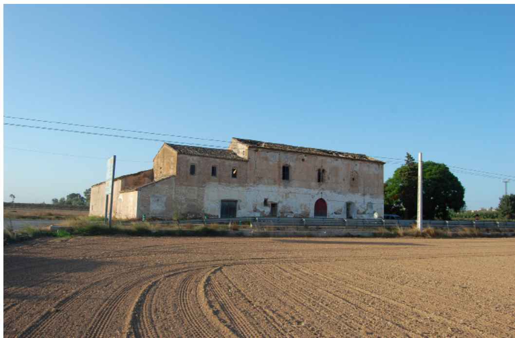
Fig. 1.- Vista exterior de la casa de Sinyent tomada desde el sudoeste. Se aprecia la edificación principal a la derecha, y las construcciones anexionadas con carácter posterior a la izquierda. Fuente: Ignacio Matoses.
