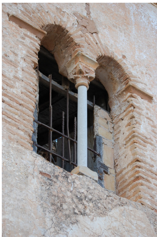
Figs. 3 y 4. Hueco geminado visto desde el exterior y desde el interior. En la primera imagen se distingue el mainel que ha perdurado. En la imagen del interior bajo el alféizar se encuentran los dos “festejadores”. Fuente: Ignacio Matoses.
