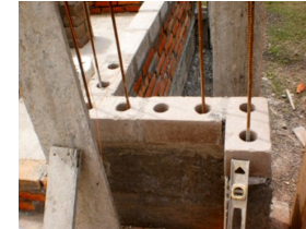
Figura 32. colocación de los bloques en las esquinas.
