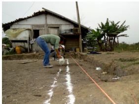
Figura 25. Colocación de cal sobre puntos replanteados.
