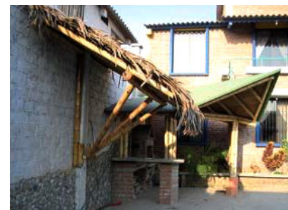
Figuras 38 a 39. Aprendimos a diversificar techumbres con estructuras de caña guadua, según necesidades, requerimientos y formas; con paja toquilla, con plancha metálica aislante en varios prototipos de vivienda, con onduline flexible en hangar de los bomberos; con paja toquilla y mortero arena cemento piedra fina sobre una cama de caña abierta en prototipo de barbacoa, y 17 con planchas de asbesto cemento en escenario frente a piscina.
