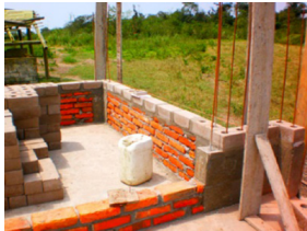
Figura 30. fila de ladrillos para colocación de instalaciones eléctricas.
