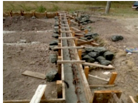
Figura 27. encofrado de muros de cimentación y colocación de varillas de 12 mm.
