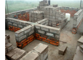
Figura 33. muros de BTC a una misma altura.
