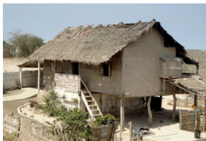
Figura 04. Vivienda tradicional de quincha en El Aromo
