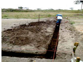
Figura 26. excavación de 0.40 mt de profundidad.
