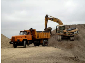
Figura 22. extracción de tierra de la cantera VIPA, para la ejecución de los BTC.
