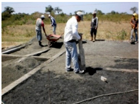
Figura 28. relleno y compactación del suelo.
