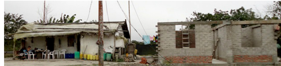
Figura 34. comparación de viviendas, mientras que la primera se ve en condiciones precarias la segunda construida con muros de BTC, se observa más sólida, compacta y sostenible. Obteniendo así el objetivo de llegar a mejorar la calidad de vida de los habitantes y de la obra.
