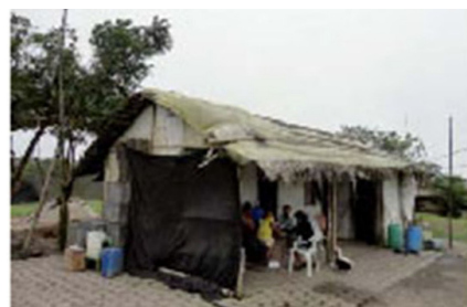
Figuras 07 y 08. Dos casas en finca en el sitio tropical húmedo El Aromo de Manta. Izqda.: mala aplicación tecnológica al exponer la caña en el exterior, está completamente deteriorada pese a tener apenas 6 años de vida útil. Dcha.: al año siguiente probamos junto a la anterior una casa "Hogar de Cristo", la empañetamos con enquinche (tierra, paja y estiércol) hicimos un baño en planta baja, y se conserva en muy buen estado a la fecha.
