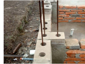
Figura 31. colocación de los bloques en paredes perpendiculares.
