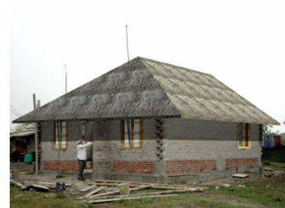
Figura 40. Montaje de la cubierta de paja toquilla. Así quedará la vivienda en su primera etapa de construcción.
