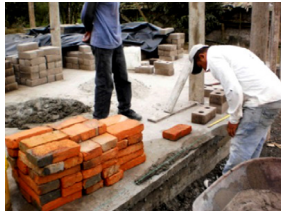
Figura 29. colocación de la primera fila de ladrillos aislantes.
