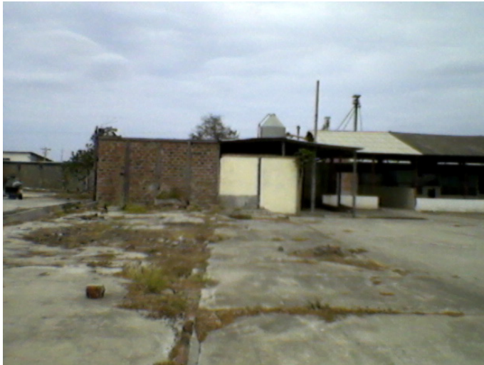
Figura 05. Galpones existente. Fuente: Estudiantes de la Facultad de Arquitectura ULEAM.
