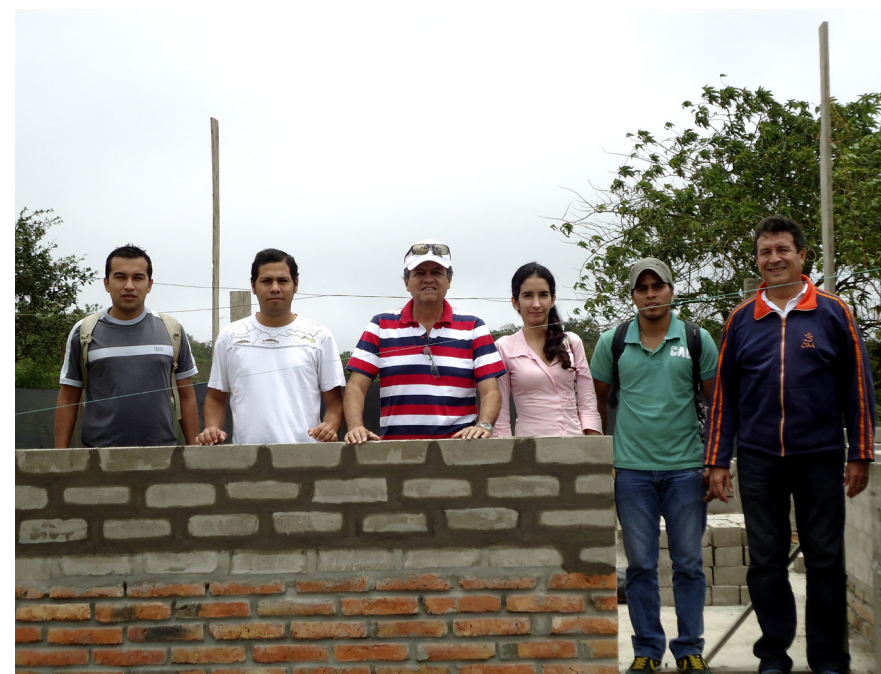
Figura 07. Prototipo de vivienda social – Sitio el Aromo. Inicio de su ejecución (Fuente Grupo de Investigación AECID – ULEAM - UVA)
