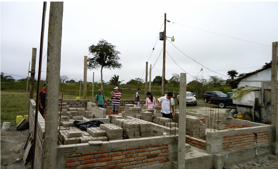
Figura 09. Prototipo de vivienda social – Sitio el Aromo. Inicio de su ejecución (Fuente Grupo de Investigación AECID – ULEAM - UVa)
