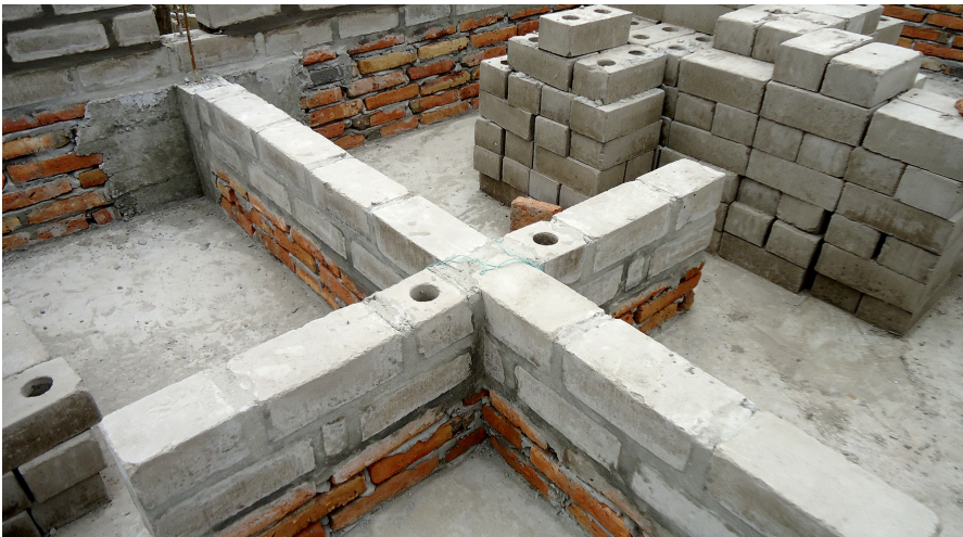
Figura 08. Prototipo de vivienda social – Sitio el Aromo. Inicio de su ejecución (Fuente Grupo de Investigación AECID – ULEAM - UVa)
