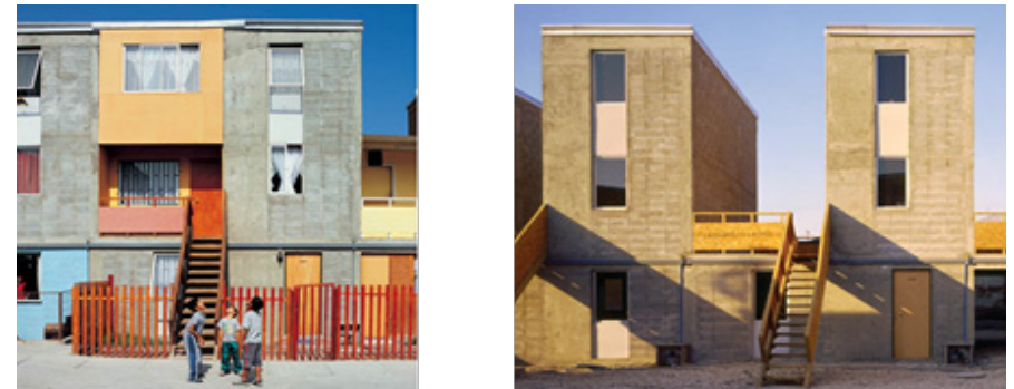
Figura 13. Vistas generales del proyecto en sus etapas finales. Elemental S.A.
