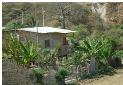
Figura 10. Viviendas de caña guadúa en las inmediaciones del Barrio las Vegas. Modelo de casas ensambladas mediante tableros de caña picada.
