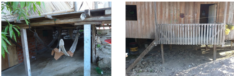
Figura 12. Vivienda elevada sobre pilaretes.
