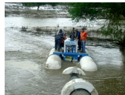
Figura 14. Bomba de Succión Flotante evacuando una de tantas inundaciones en Cantón Chone.
