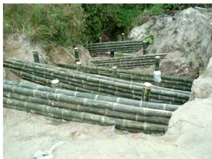
Figura 25. PueMuros "Trincho" de caña guadúa en quebradas para evitar deslizamientos. Sitio el Resbalón
