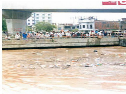
Figura 17. La noche anterior salieron los 2 ríos secos Burro y Manta. Puente céntrico a punto de colapsar.
