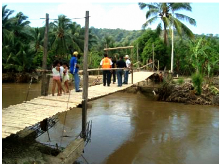
Figura 20. Puente emergente de Guadúa realizado por la comunidad el Resbalón de Rocafuerte.
