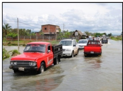
Figura 09. Vías destruidas- Cantón Rocafuerte.
