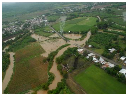
Figura 23. Destrucción de vía y puente en la periferia de Portoviejo. Inundación y pérdida de cauce del río por deforestación.
