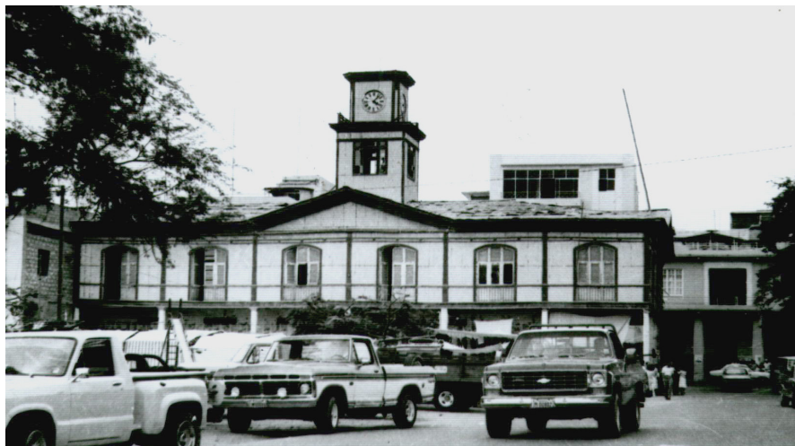
Figura 02. Antiguo edificio de Autoridad Portuaria, expresa la tipología constructiva de la época.
