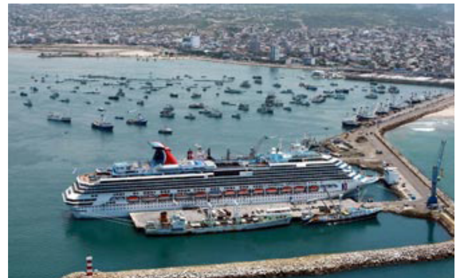
Figura 10. Vista del Puerto de Aguas Profundas.
