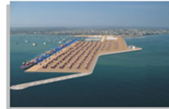
PUERTO DE TRANSFERENCIA
